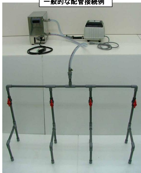
一般的な配管接続例
